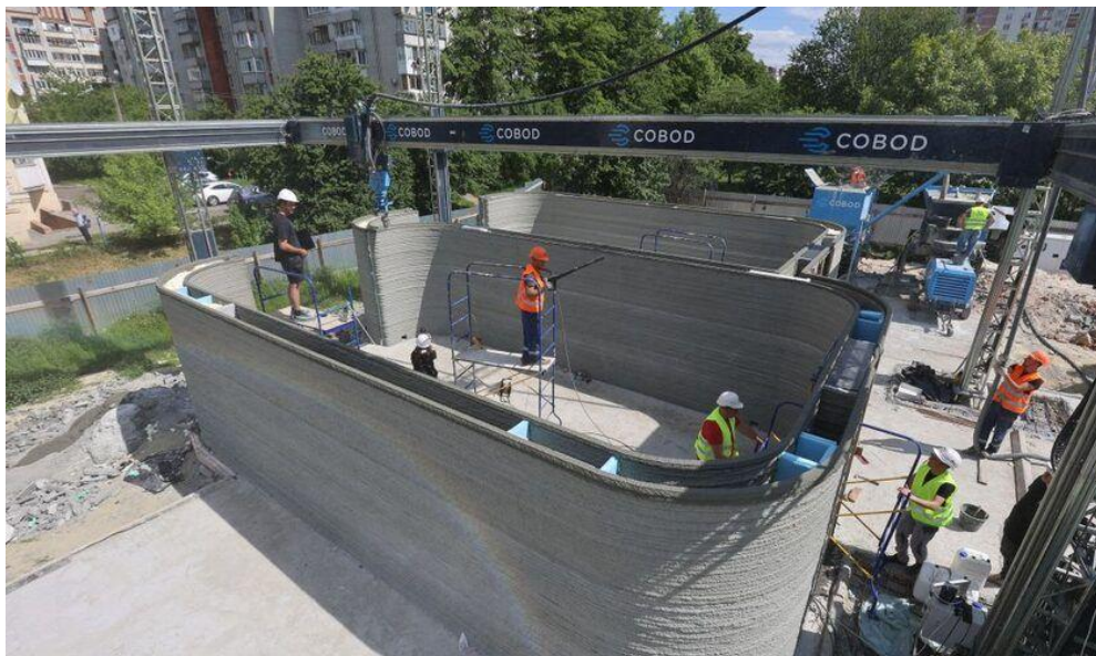
Рис. 1 – Процес друкування будівлі
