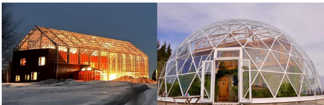
Рис. 1 – Вид на будівлі зі стандартним та купольним скляним контуром.
