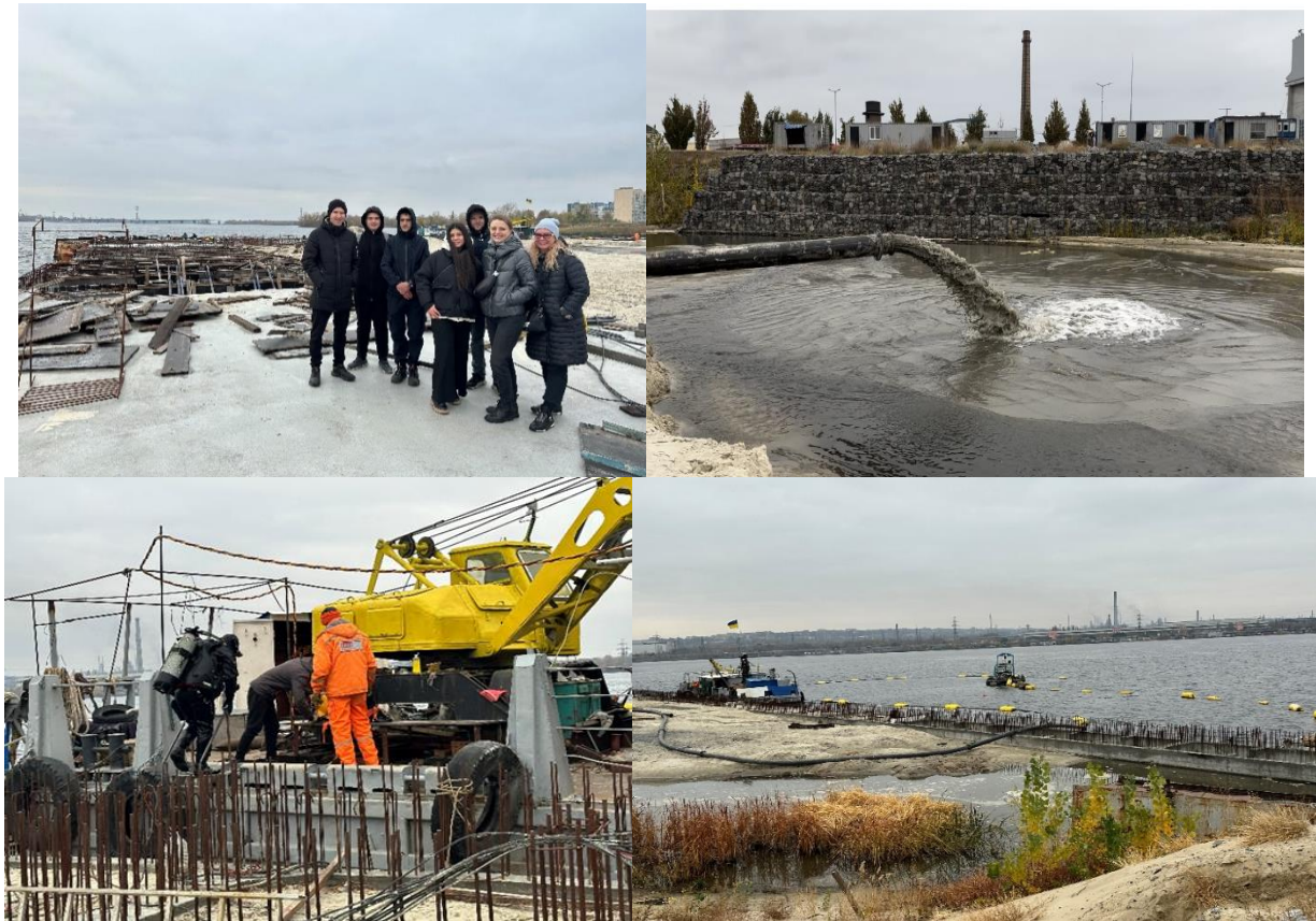
Рис. 3 – Гідротехнічне будівництво з використанням масивів-гігантів
