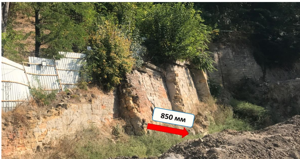
Рис.2. – Ділянка дослідження та деформації існуючих протизсувних споруд.
