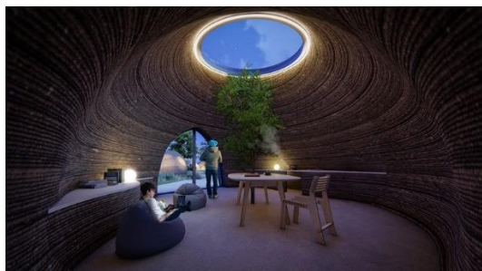
Рис.1 – Інноваційний будинок TECLA, сконструйований за принципом осинового гнізда та надрукований на 3D-принтері з глини з додаванням соломи (саманом)
