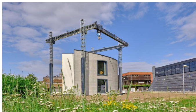
Рис.2 – Двоповерховий будинок, побудований на 3D-принтері «Камр С» з бетону у Бельгії
