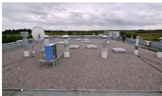
Рис.3 – Покрівля з гравійною засипкою
