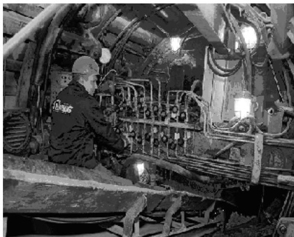
*Рисунок 5 – Будівництво каналізаційного колектору за допомогою прохідницького щита*
