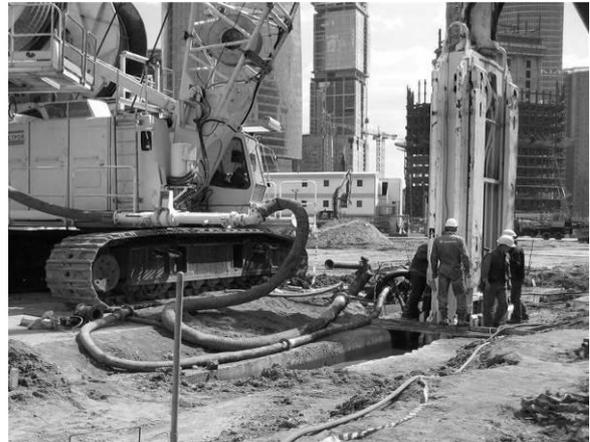
Рисунок 4 – Технология строительства методом «стена в грунте»
