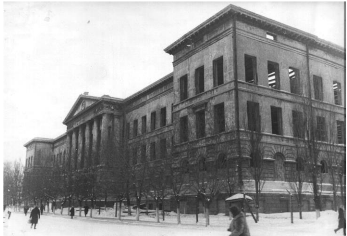
Восстанавливается главный корпус ДГИ. 1948 год
