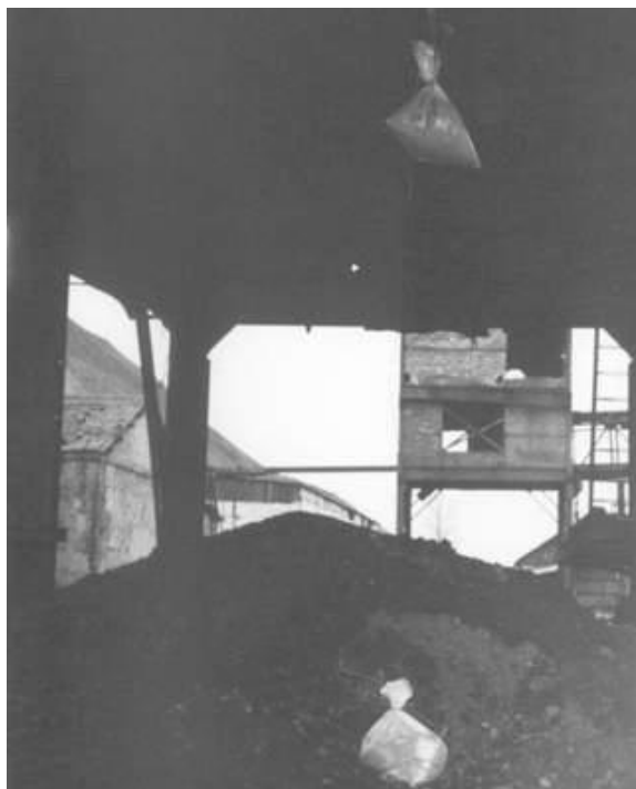
Рис. 1. Расположение снаряженных сосудов с цементно-песчаной смесью массой 20 кг на закрываемой шахте «Новгородовская»
