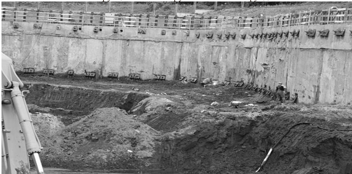
Рис. 1. Стена в грунте
