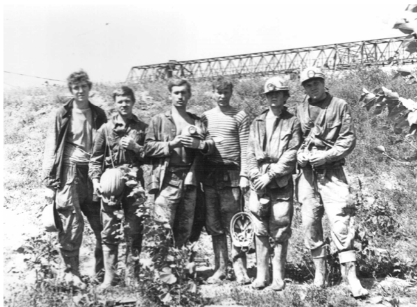
Строительный отряд «Шахтостроитель-72»
